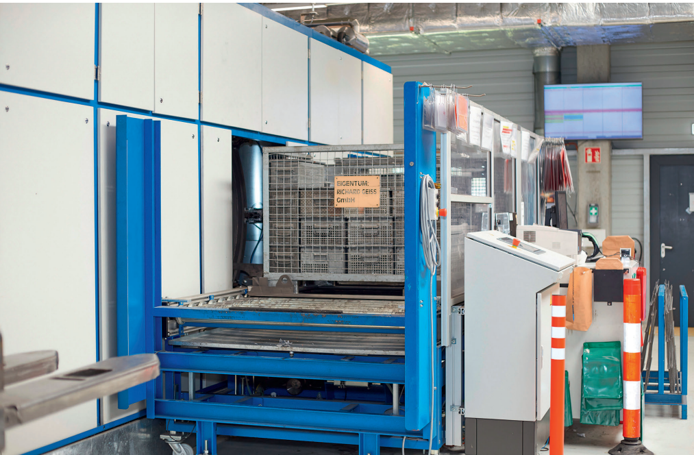
1 Die Lohnentfettungsanlage reinigt die Teile der ElringKlinger AG porentief von Öl und anderen Partikeln © Richard Geiss
